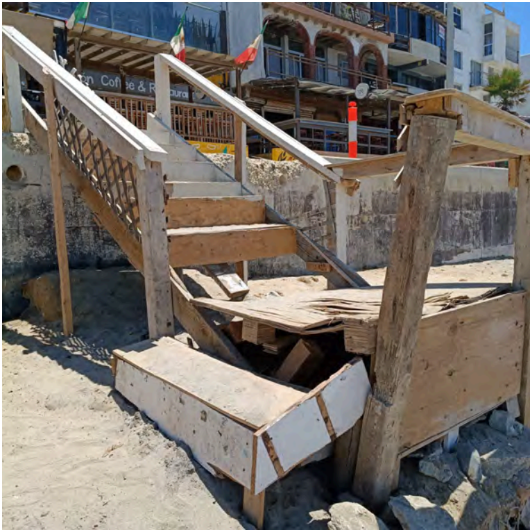
Ilustración 28. Autoconstrucción. Detalle de los materiales que fueron usados en la construcción de las escaleras. Fuente: Deriva territorial. Autor: Crisna Donaji Sánchez Ramírez. Fecha: 21 de marzo de 2025.
