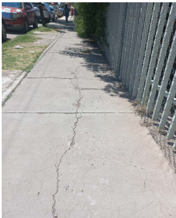
Fotografía 3.1 Banqueta alrededor del edificio escolar
