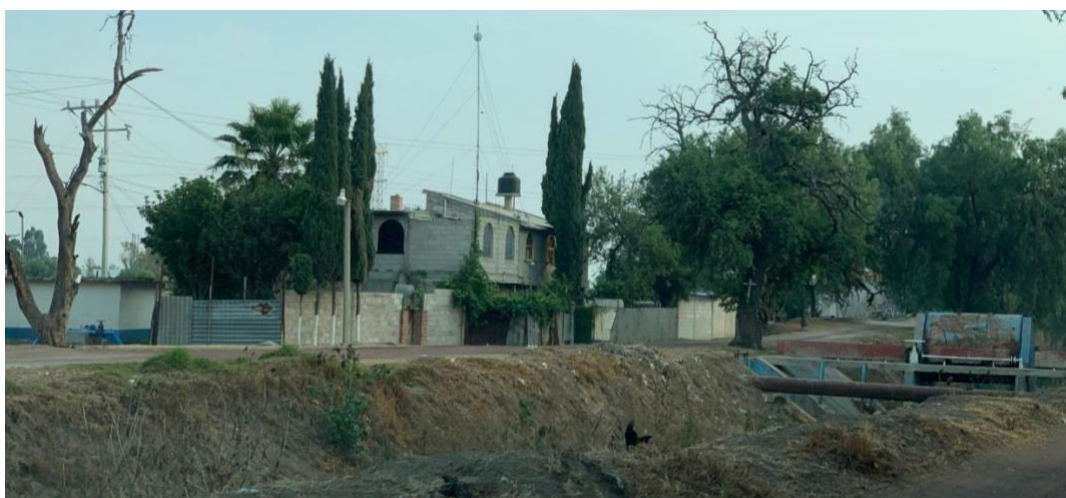
Figura 4.4. Caseta de bombeo de agua potable (izquierda) y sistema de compuertas del río San Juan (derecha). San Bartolo, Acolman.
