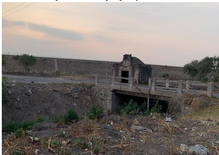
Figura 3.6. Vista a la compuerta llamada “El Castillo” en la intersección con el río San Juan, entre el pueblo de Tepexpan y Cuanalán, Acolman
