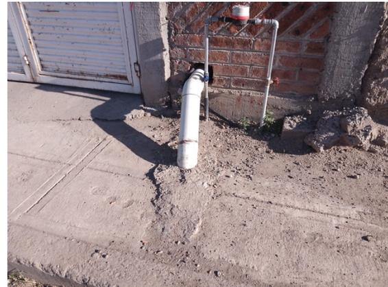
Figura 27. Descarga de drenaje y micromedidor de una vivienda (archivo propio).
