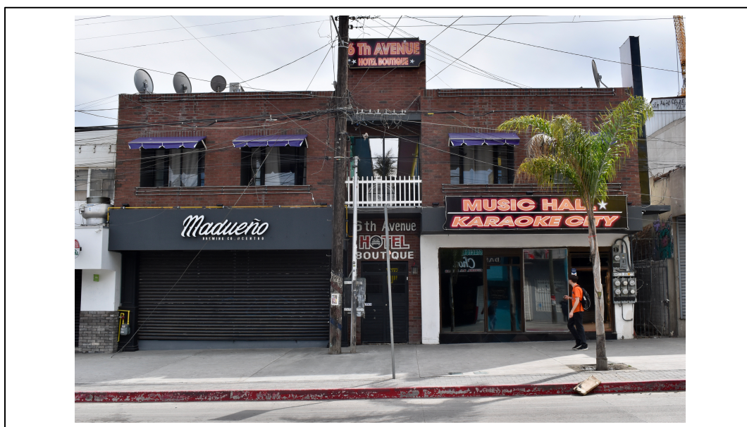
Imagen 2.3 Edificio remodelado en Calle Sexta
