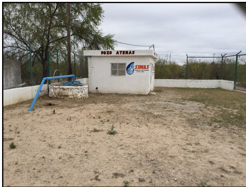
Ilustración No. 18.- Pozo ubicado entre las calles Melchor Ocampo y Diógenes.
