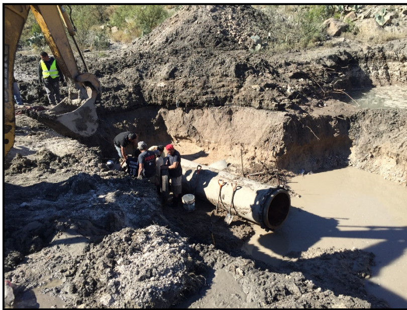
Ilustración No. 7.- Fuga en la línea principal de abastecimiento de agua potable de la Región Carbonífera, en la localidad de La Florida. Fotografía propia tomada el 6 de diciembre de 2019.
