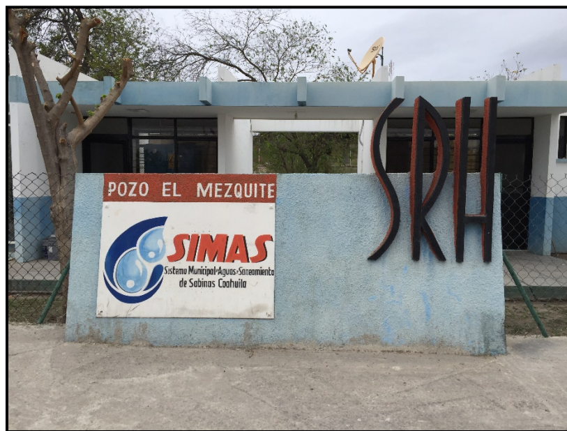
Ilustración No. 14.- Pozo “El Mezquite”, construido por la Secretaría de Recursos Hidráulicos.
