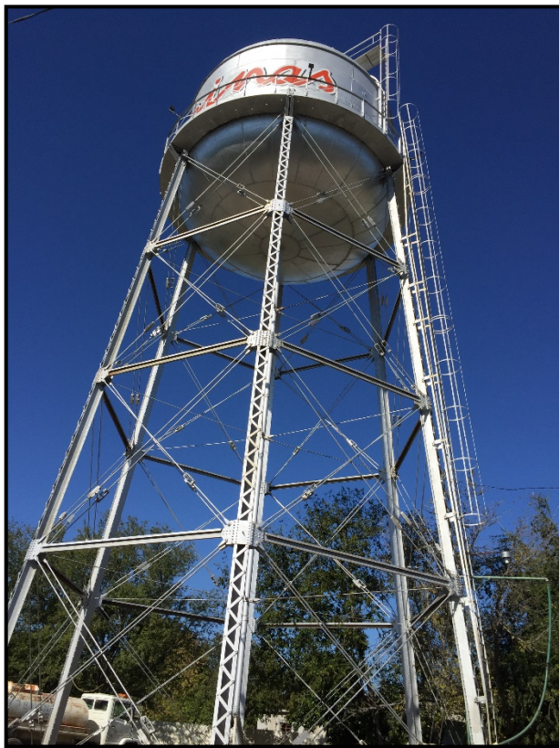
Ilustración No. 20.- Tanque elevado que se encuentra fuera de operación pero que conforma un patrimonio en el abastecimiento del municipio de Sabinas.
