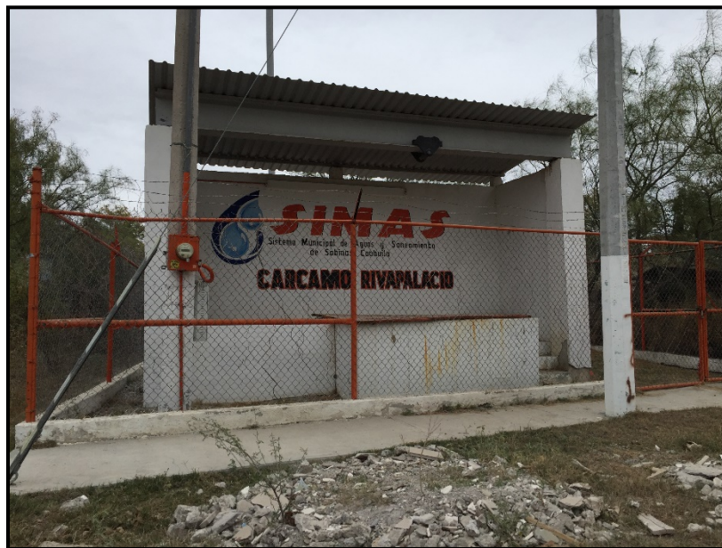
Ilustración No. 16.- Fachada del cárcamo ubicado en la colonia Sarabia, cercano a los márgenes Río Sabinas, en la calle Sabinal.
