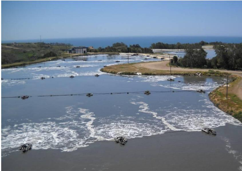
En esta foto se puede apreciar que la línea de aireadores ubicada en el centro de la laguna de la oxidación no está en funcionamiento; de hecho, estos equipos de aireación se encuentran montados por vegetación, lo que sugiere que ha transcurrido algún tiempo desde que dejaron de operar.
