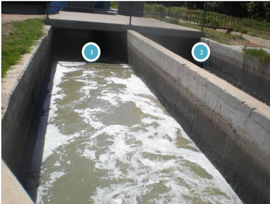
En la foto se aprecian los dos canales de conducción de las aguas negras. El primero dirige el flujo hacia el interior de la planta de tratamiento, mientras el segundo es un canal de excedencias que transporta las aguas fuera del sistema.
